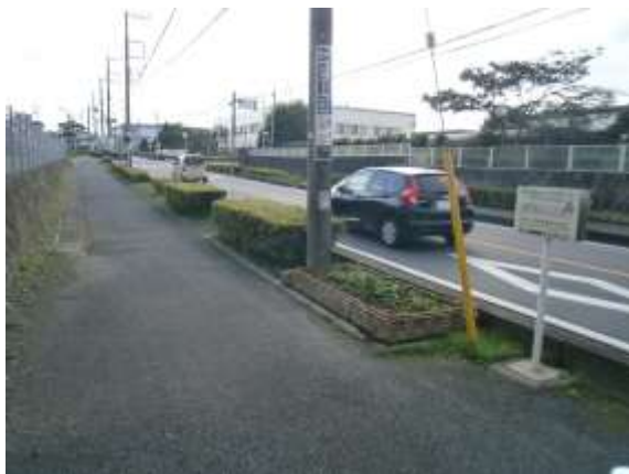
■ 令和元年 7 月 24 日 清掃と除草作業
